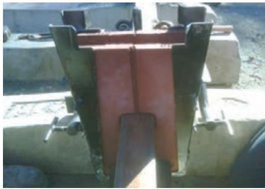
شکل ۱۸- نصب قالب اطراف ناحیه اتصال
