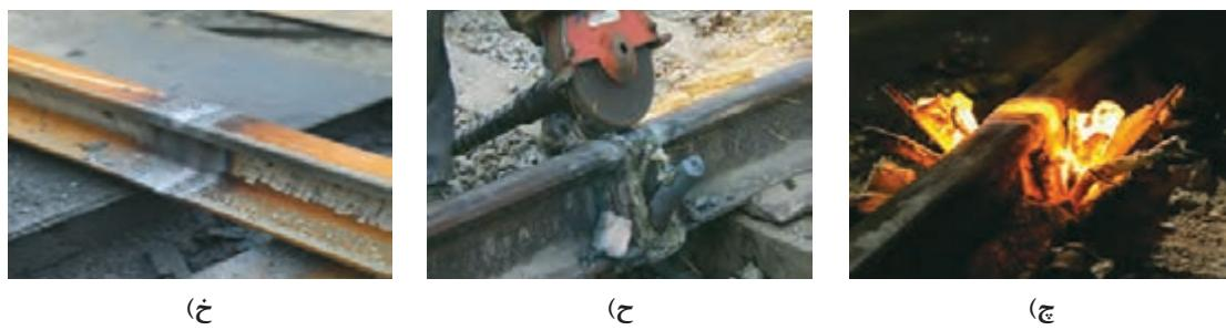
شکل ۱۴-مراحل جوشکاری ترمیت خطوط راه آهن
