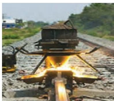
همانطور که گفته شد جوشکاری ترمیت به طور گسترده در ایجاد خطوط راه آهن پیوسته و تعمیر آن استفاده می‌شود. در اثر عبور قطارهایی با وزن زیاد فشارهای شدیدی به ریل‌های راه آهن وارد شده که می‌تواند باعث ایجاد ترک در ریل‌های راه آهن شود. تعمیر این ترک‌ها از نظر حفظ امنیت مسافران بسیار حائز اهمیت است.
