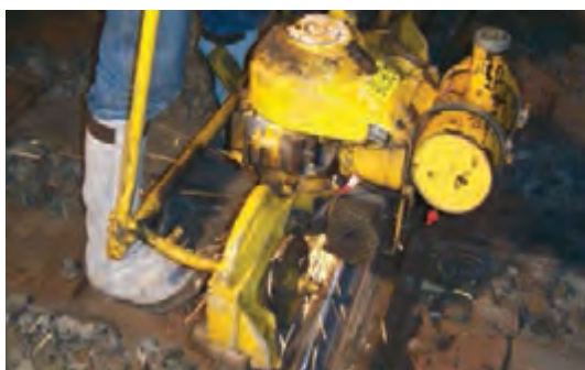
شکل ۲۵- سنگ زنی و پرداخت کاری سطح گرده
