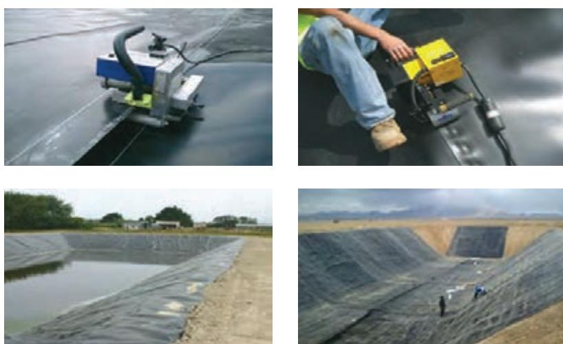
شکل ۱۴- جوشکاری عایق‌های پلاستیکی (ژئومبران) استخیرهای ذخیره آب
