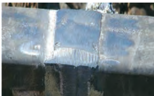
شکل ۲۶- نمایی از سطح جوش
