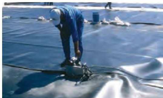
شکل ۱۲- دستگاه جوشکاری گاز داغ و جوشکاری با گاز داغ به صورت ماشینی
