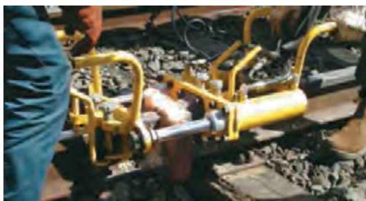
شکل ۲۴- برش گرده اضافی جوش
