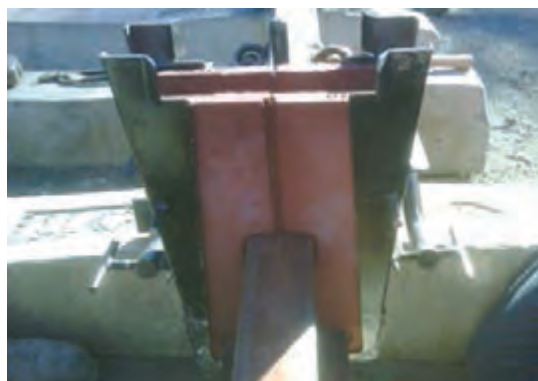
شکل ۱۸- نصب قالب اطراف ناحیه اتصال
