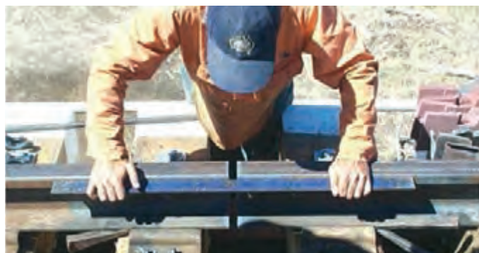
شکل ۱۷- کنترل هم راستایی سطح جانبی ریل با استفاده از تراز بلند
