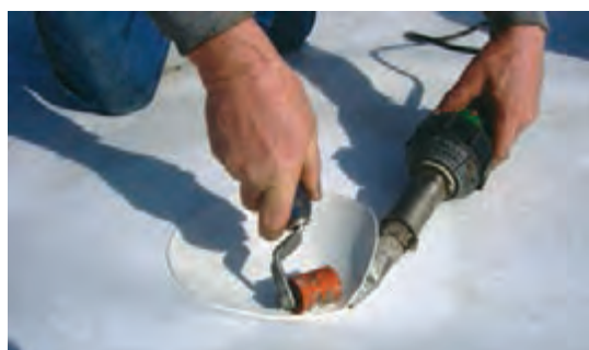
شکل ۱۱- جوشکاری با گاز داغ به صورت دستی
