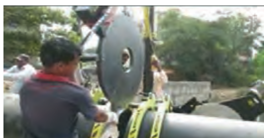
شکل ۱۸- جوشکاری لب به لب Butt Fusion
