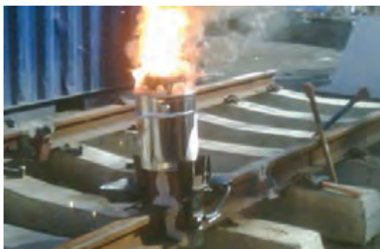
شکل ۲۱- نمایی از انجام واکنش ترمیت
