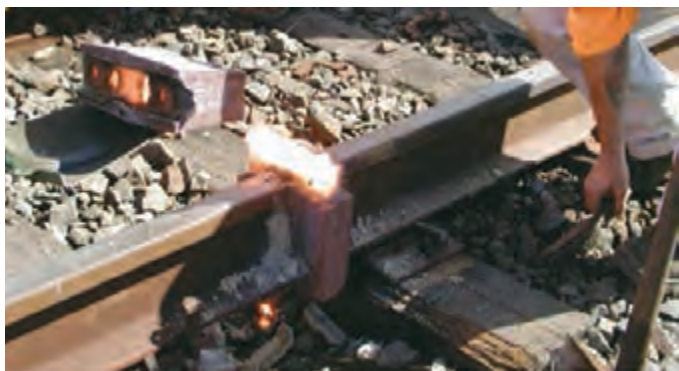
شکل ۲۳- شکستن قسمت فوقانی قالب
