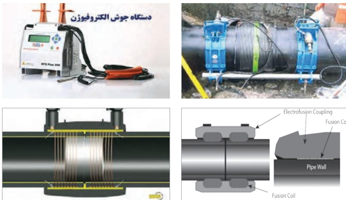
شکل ۱۷- جوشکاری الکتروفیوزن
