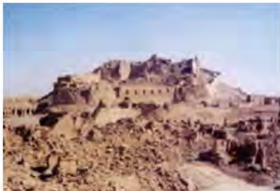
ب) ارگ بم بعد از زلزله
