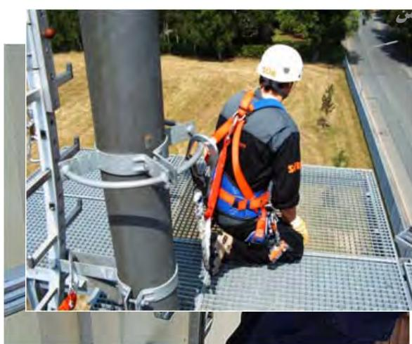
شکل ۱۱۱- سامانه محیبود کننده با استفاده از ریل
