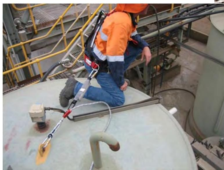
شکل ۵۷- محدود کننده با اتصال یک طناب
