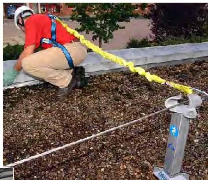
شکل ۵۶- محدود کننده با اتصال یک طناب
