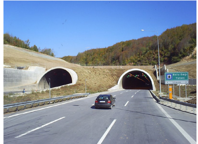
Fig. 3. Bolu tunnel portal (Lubunya, 2014).
