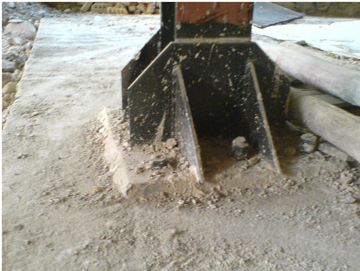
صفحه ستون با بولت پيچى/اتصال گيردار(درجهت X) و مفصلى(درجهت Y) پاى ستون
