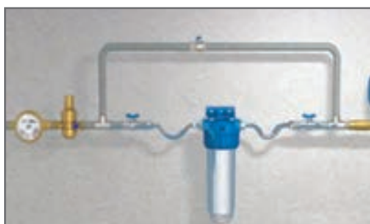
شکل ۶- روش نصب سختی گیر پلی فسفات
