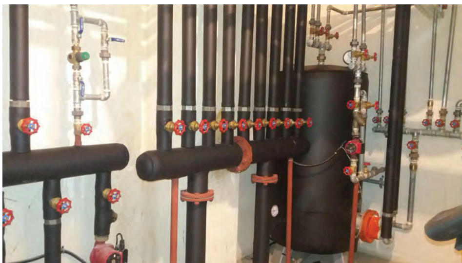
شکل ۲۵- عایق کاری در موتورخانه
