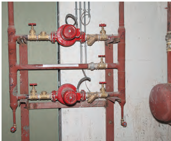
شکل ۲۴- اتصال شیر تخلیه
