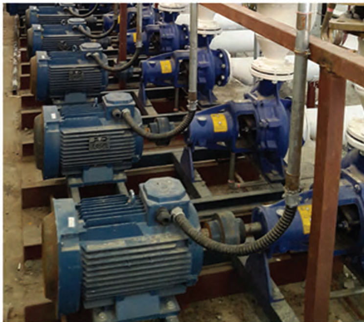
شکل ۲۴- اتصال موتورهای سه فاز
