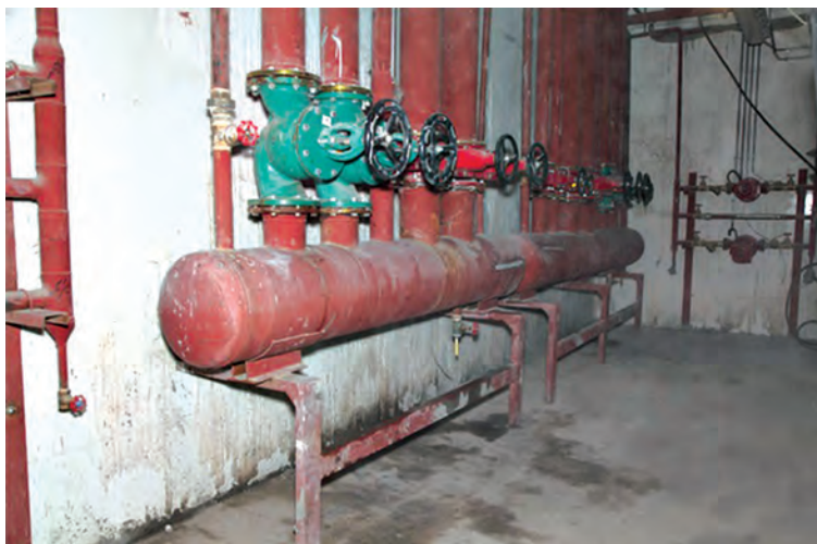
شکل ۱- نصب شیر تخلیه کلکتور
