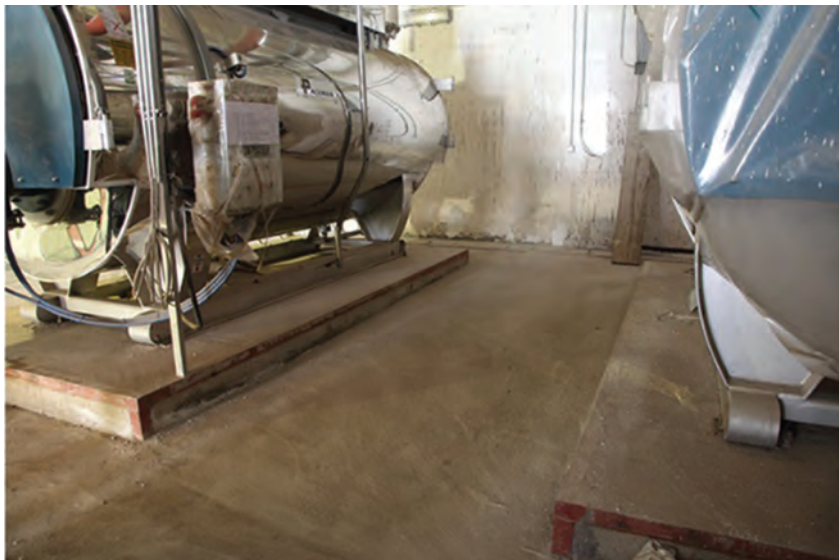
شکل ۱۴ - نصب دیگ روی فونداسیون
