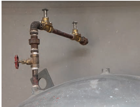
شکل ۲۳- اتصال لوله هواگیری مخزن
