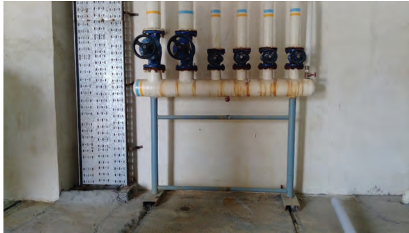
شکل ۲- نصب پایه کلکتور
