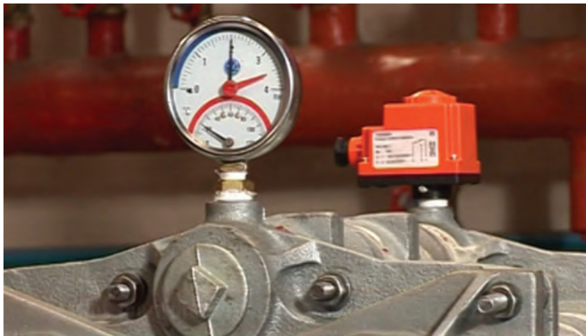
شکل ۲۱- نصب کنترل کننده و نشان دهنده دیگ
