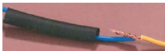
شکل ۲۲- عایق‌کاری اتصال
