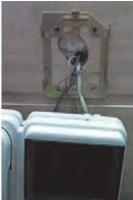
شکل ۱۱- پایه و نحوه نصب آن صفحه نمایش در بازکن
