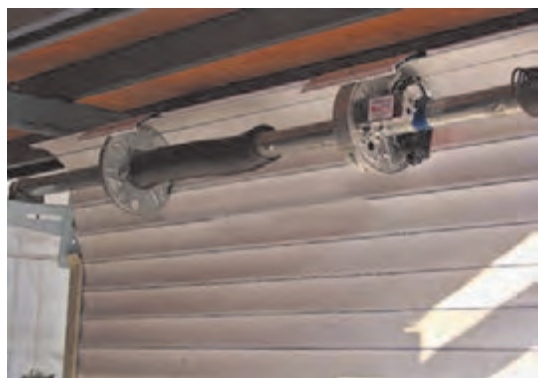
شکل ۱۱- محل نصب موتور کرکره‌ای
