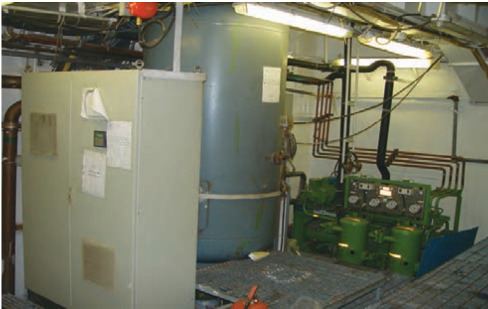
شکل ۱۷- سامانه هوای فشرده
