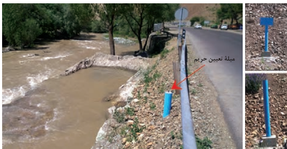
میلۀ تعیین حریم سیل گیر رودخانه کرج در بالادست سد امیرکبیر
