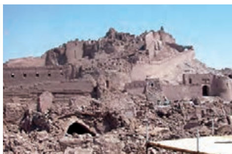
ارگ بام، بزرگ‌ترین سازه خشتی جهان در زلزله بام دچار تخریب زیاد شد.
