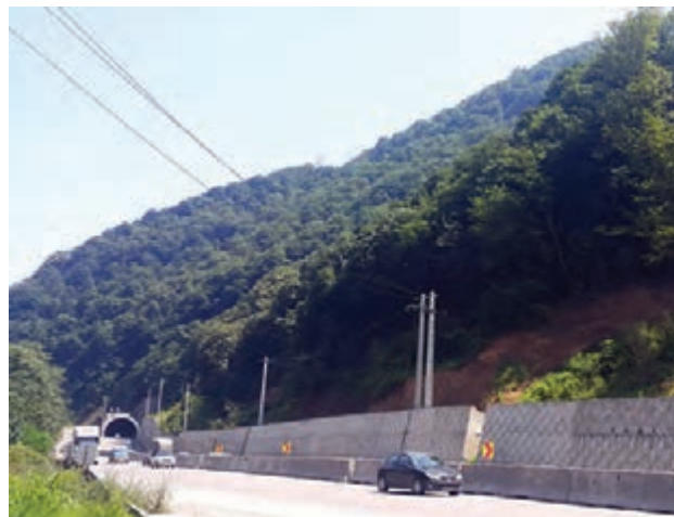
نصب حفاظ بتونی - جاده قائم‌شهر
