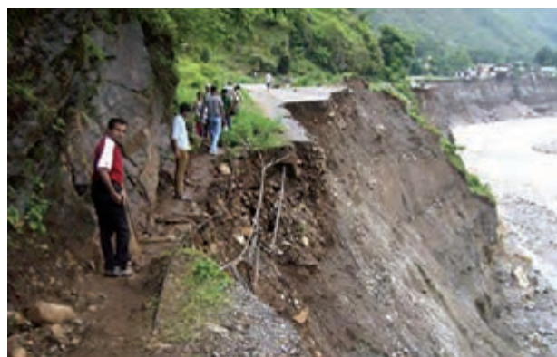
لغزش در اثر زیربُری رودخانه در هند
