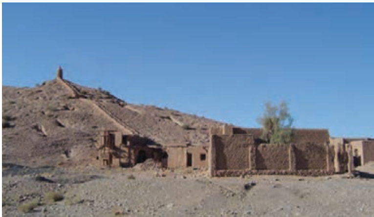
شکل ۸-۷- کوره و دودکش تأسیسات ذوب فلز در معدن سرب - اصفهان
