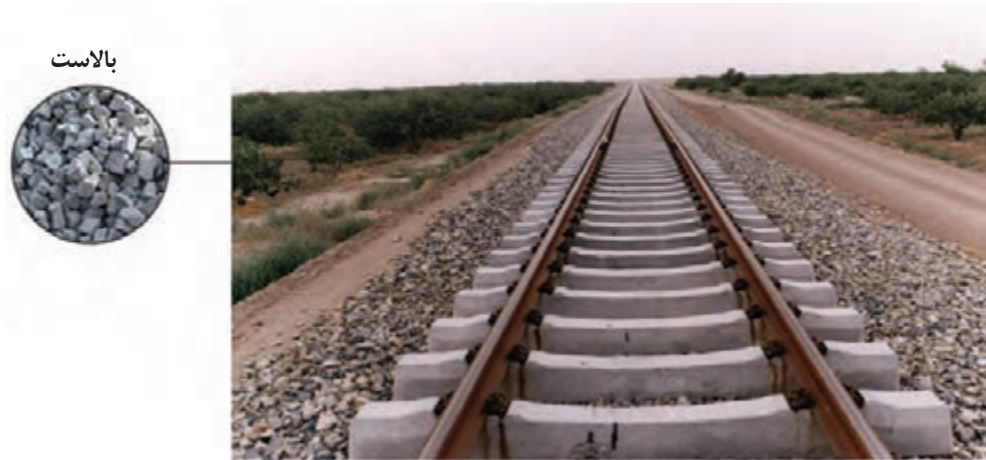
شکل ۲۳-۶. بالاست استفاده شده در زیرسازی جاده ریلی
