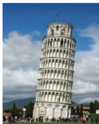
شکل ۱-۶ نشست نامتقارن پی در برج پیزا
