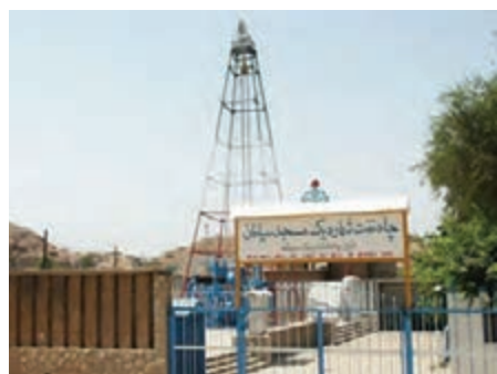
شکل ۱۲-۷. چاه شماره یک مسجد سلیمان
