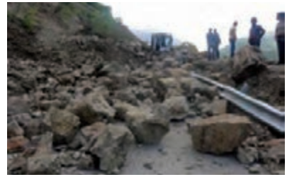
شکل ۱۲-۶- ریزش مصالح
