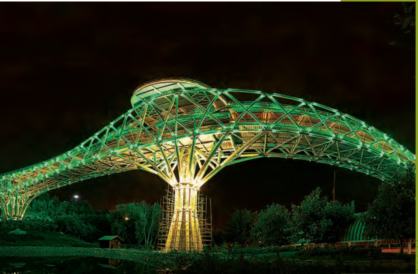
پل طبیعت تهران
