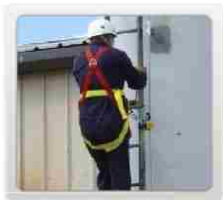
شکل ۷۶- صعود از تردمان با ابزار متوقف‌کننده
