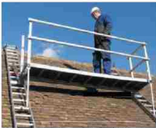
شکل ۳۰- جابجاده کار روی سطوح شیبدار
