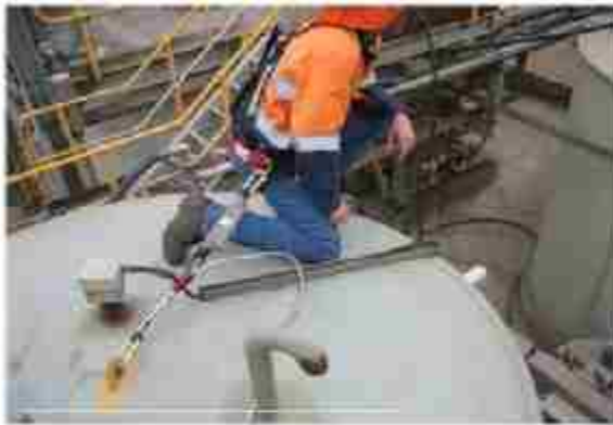
شکل ۳-۵۴ محدودکننده با اتصال یک نقطه
