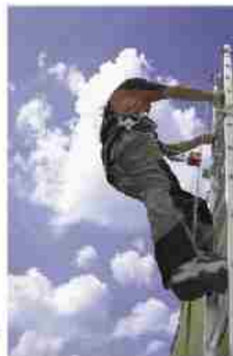
شکل ۷۷- صعود از تردمان با ابزار متوقف‌کننده
