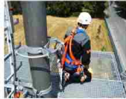
اشکال ۱۱۱- سایبان محدودکننده با استفاده از ریل
