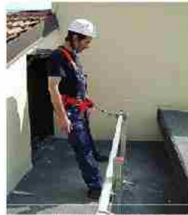
شکل ۴-۵۴ محدودکننده با اتصال یک ریل مخصوص
