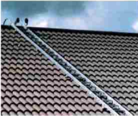
شکل ۱- نحوه استقرار تودبان سقفی
