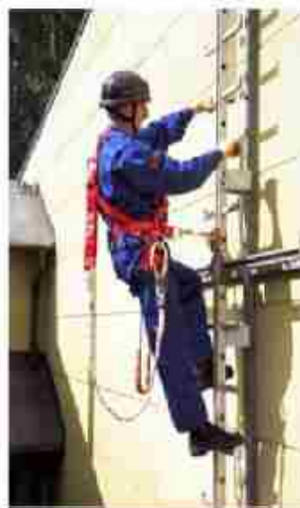
شکل ۱۱۰ - سمانانه متوقف کننده یا استانه از ویل مخصوص در تارتنس
