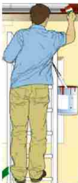
شکل ۱۳- نحوه استقرار صحیح برای کار
