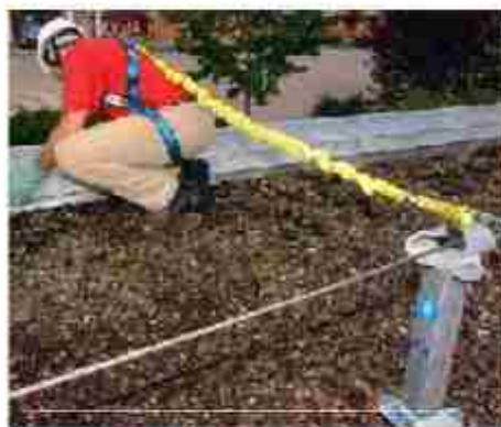
شکل ۵۴-۲ محدود کننده با اتصال یک قطب
