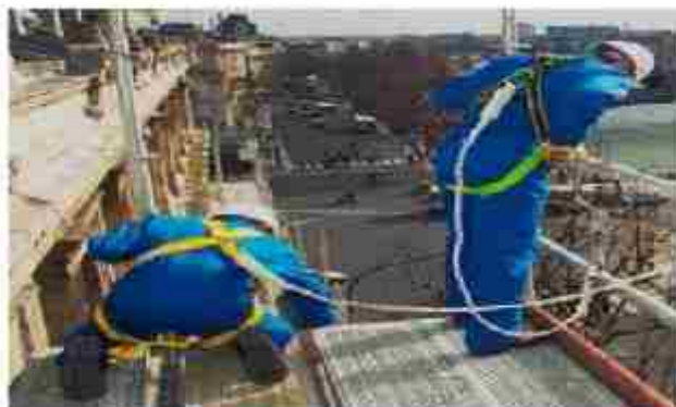
شکل ۷۷- صعود از تردمان با ابزار متوقف‌کننده
