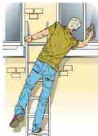
شکل ۱۱- استقرار غلط برای کار
