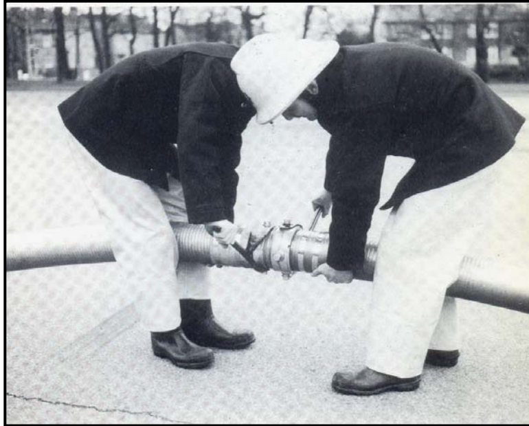
روش صحیح بستن شیلنگ های خرطومی به یکدیگر
