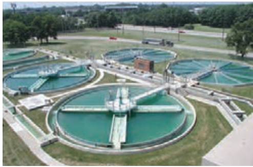
تصفیه آب در تصفیه خانه
