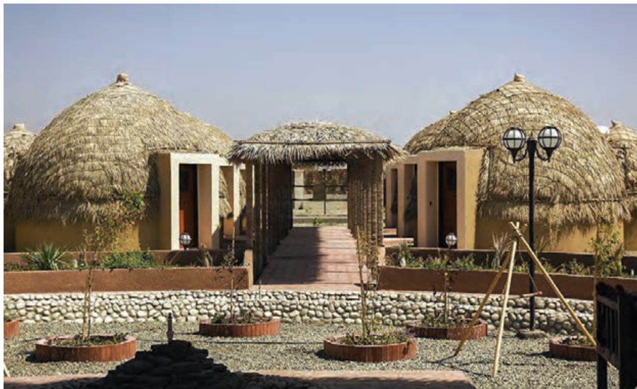
شکل ۱۷- مهمان پذیرهای کبری در قلعه گنج کرمان- نوعی از اقامتگاه های سازگار با محیط زیست
