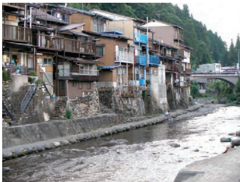
شکل ۱۶- عدم رعایت حریم آب
