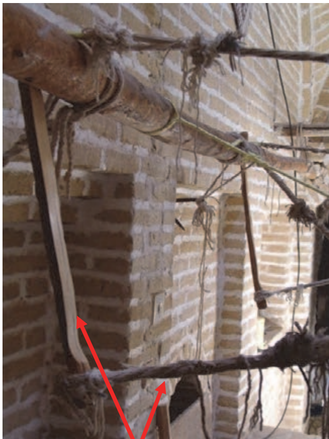
شکل ۳۶- کمونه و نخ اتصال آن
