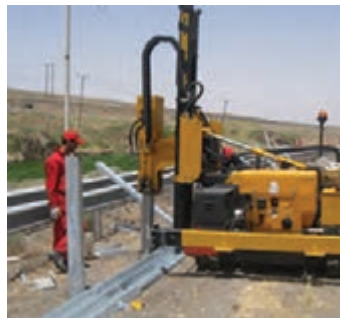
شکل ۴۲- پایه‌کوبی بعد از ریلی کردن سپری‌ها
