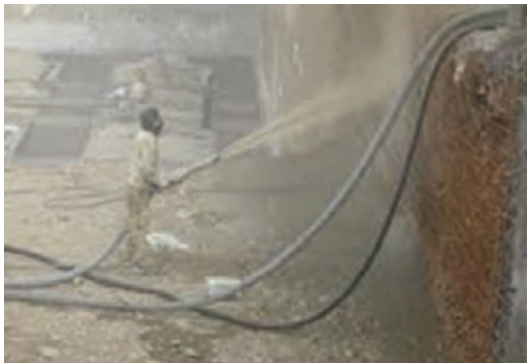
شکل ۲۰- اجرای بتن پاشی (شاتکریت) در بدنه سد
