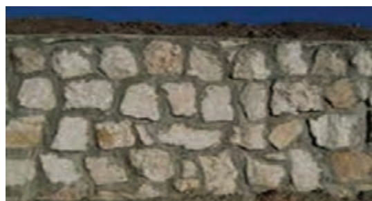
شکل ۱۷- استفاده از ملات در دیوارهای سنگی
