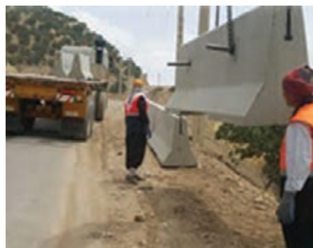
شکل ۵۹- نمونه‌هایی از حمل و نصب نیوجرسی با جرثقیل
