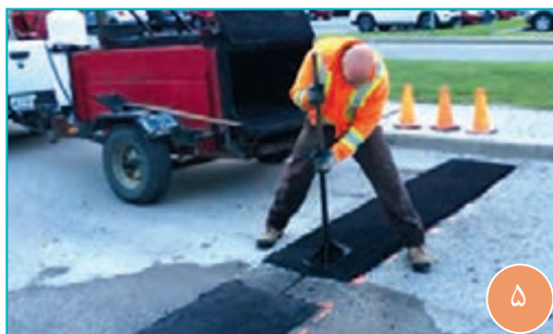
شکل ۷- مراحل اجرای سرعت گیر آسفالتی
