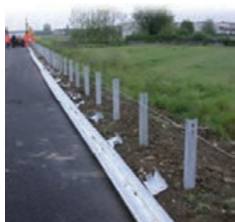
شکل ۴۳- نمونه‌ای از نصب پایه‌های گاردریل با ریسمان‌کشی
