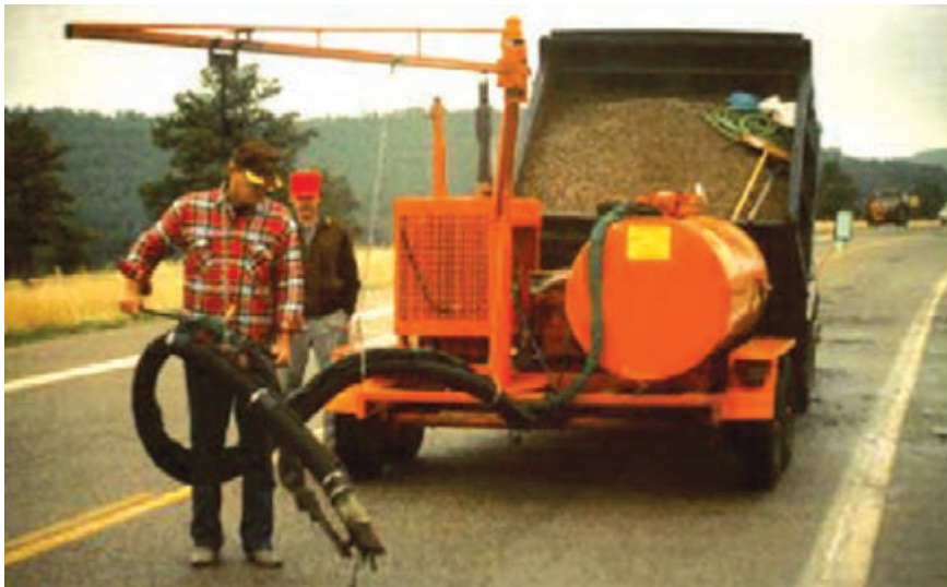
شکل ۴۴- تجهیزات تزریق فشاری
