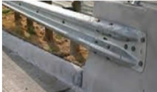
شکل ۸۱ - ناحیه انتقالی حفاظ دو موج به نیوجرسی
