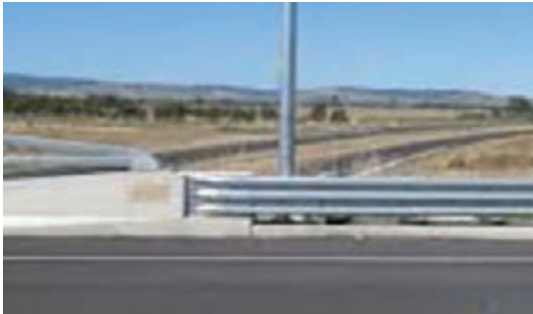
شکل ۸۲ - ناحیه انتقالی حفاظ سه موج به نیوجرسی
