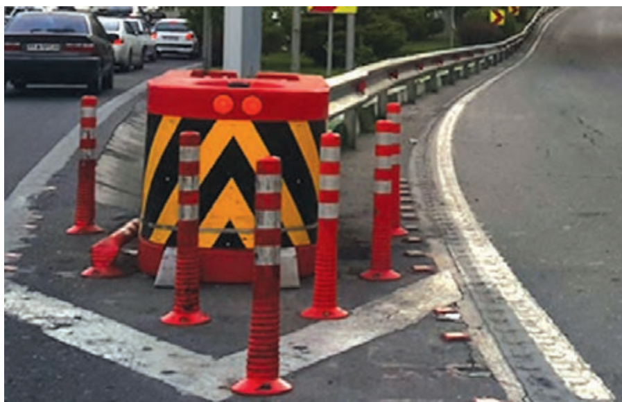
شکل ۲۱ - اجزای ضربه گیر ریلی در تهران
