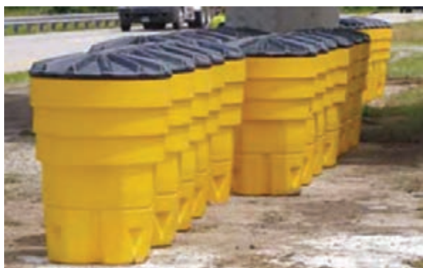
شکل ۲۷- طریقه نصب و چیدمان صحیح ضربه‌گیرهای بشکه‌ای
