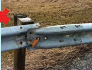
شکل ۱۵- نصب نامناسب گاردریل به دلیل عدم اتصال با پیچ و مهره
