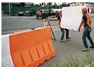
شکل ۳۰- حمل حفاظ پلاستیکی برای نصب در مسیر
