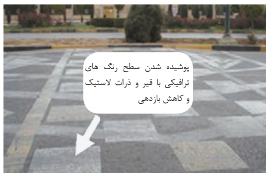
شکل ۳۱- دید ضعیف خطوط میانی و خطوط هشدار دهنده موجود بر روی سرعت‌کاه در روز
