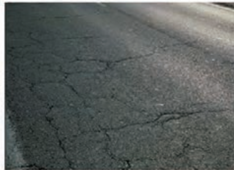
شکل ۳- ترک‌های بلوکی
