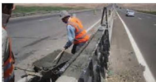
شکل ۲۳- تعمیر حفاظ بتنی (نیوجرسی) در محل
