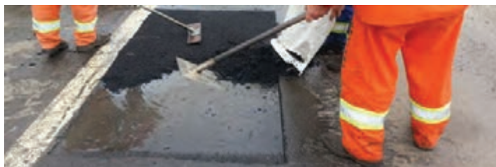
شکل ۳۶- عملیات لکه‌گیری
