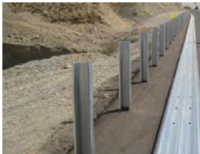
شکل ۴۲- پایه‌کوبی بعد از ریلی کردن سپری‌ها
