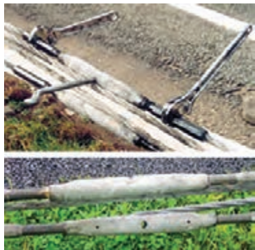
شکل ۴۸ - تنظیم کشش کابل
