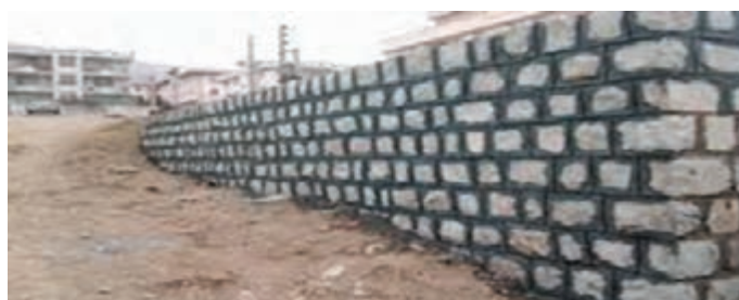
شکل ۱۵- نمایش ساخت دیوار سنگی با رعایت اصول دیوار چینی
