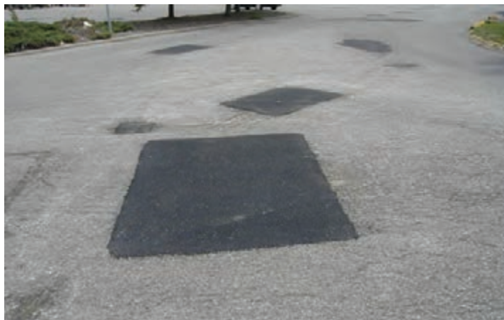
شکل ۹- نمونه‌ای از لکه‌گیری در روسازی آسفالتی
