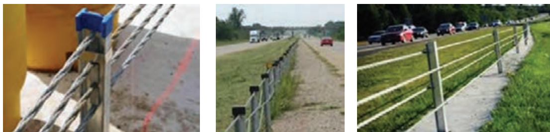
شکل ۴۶- نمونه‌هایی از اتصال کابل به پایه‌ها
