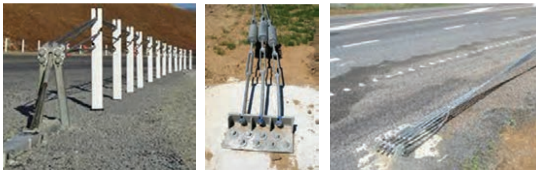
شکل ۲۰- نمونه‌هایی از انواع مهارهای حفاظ کابلی
