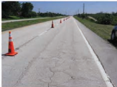
شکل ۳- ترک‌های بلوکی
