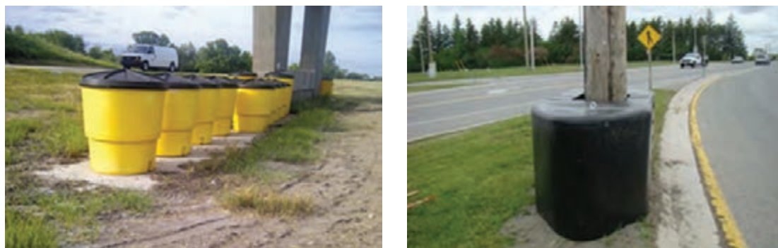
شکل ۲- استفاده از ضربه‌گیرها برای افزایش ایمن‌سازی موانع سخت موجود در حاشیه راه
