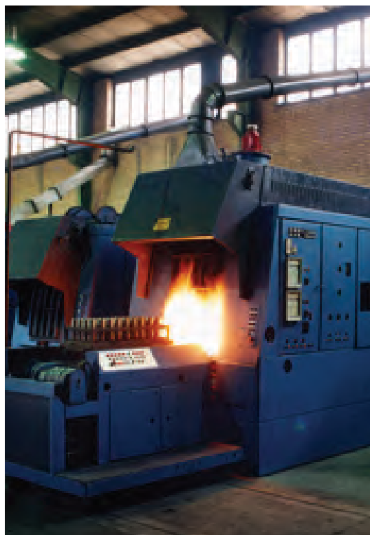
شکل ۳۱- کوره کربورایزینگ گازی
