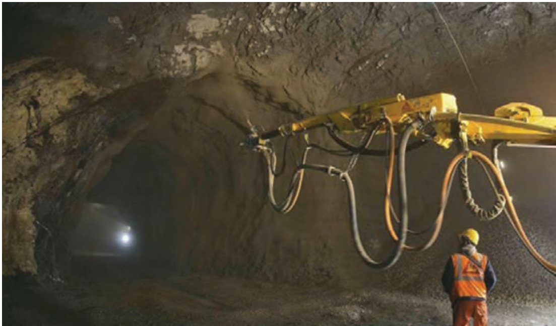
پاشیدن سیمان پوششی بر روی دیواره و سقف تونل
