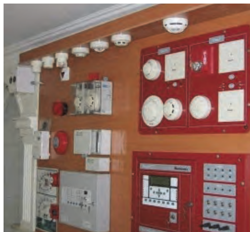
شکل ۹-۴- نمونه‌هایی از سیستم‌های اعلان حریق و کاشف‌ها
