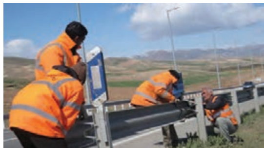
شکل ۷- نصب گاردریل کنار راه
