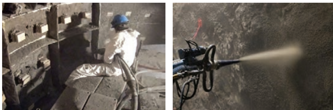
شکل ۲۸- نصب جرم با روش پاشش
