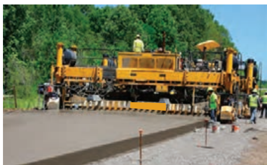
اجرای روسازی بتنی با استفاده از دستگاه
