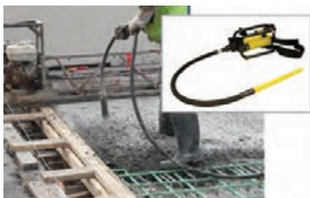
تراکم بتن تازه با دستگاه ویبره
