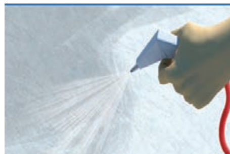
پاشیدن مواد نگهدارنده رطوبت بر سطح بتن
