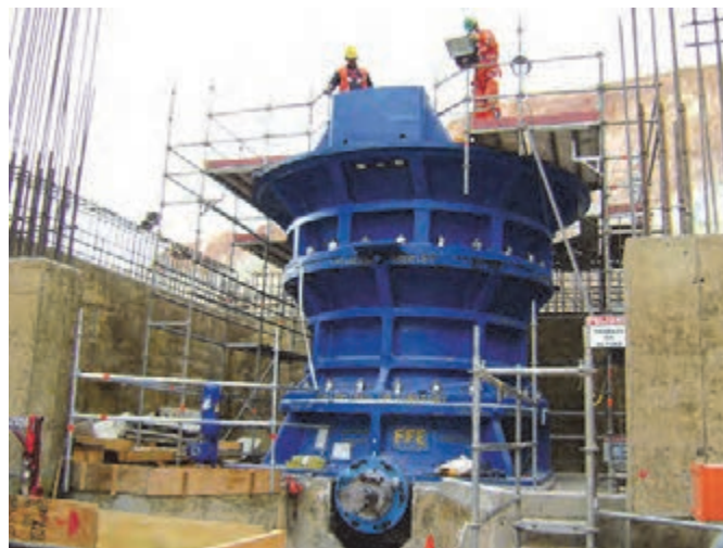
دستگاه سنگ شکن ژیراتوری در حال نصب بر روی فونداسیون
