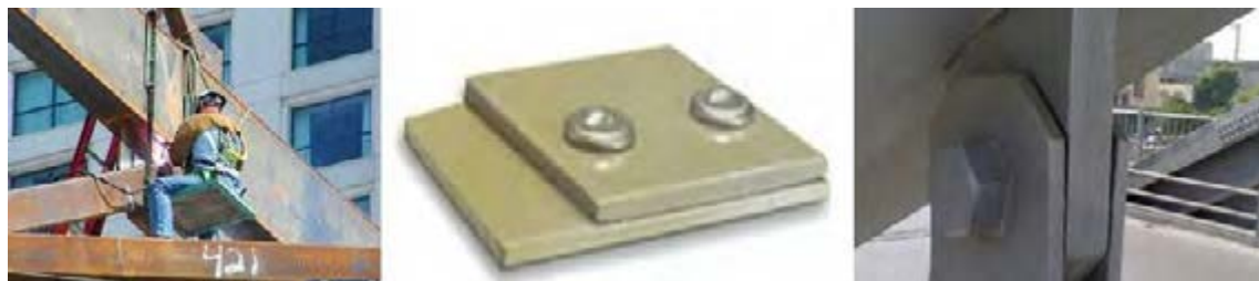
شکل ۱- روش مونتاژ به طریق پیچ و مهره، پرچ‌کاری و جوش‌کاری
