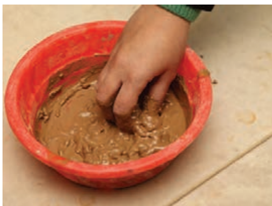
شکل ۱۰- تهیه گل یکنواخت با دوغاب
