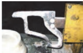
ب) نصب و تنظیم شابلون
