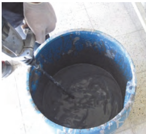
شکل ۱۸- هم زدن دوغاب قبل از ریخته‌گری
