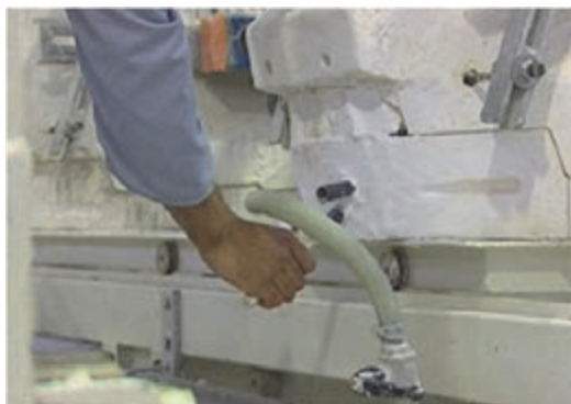
شکل ۳۵- باز کردن لوله‌ها جهت تخلیه دوغاب اضافی
