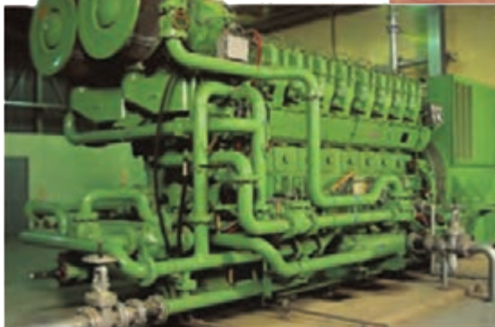
موتور ژنراتور یک نیروگاه برق اضطراری معدن
