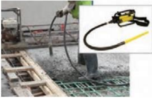
تراکم بتن تازه با دستگاه وایبره
