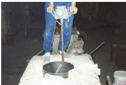
شکل ۱۹- نحوه کوبش دیواره کوره توسط کوبه ماشینی
