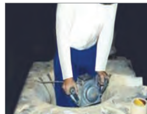
شکل ۱۳- کوبیدن نسوز کف کوره با کوبه ماشینی
