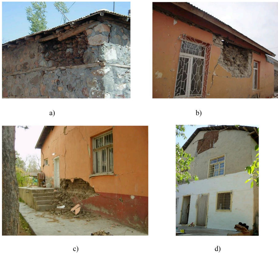
Fig. 23. Damages to masonry walls for various earthquakes, a) Bingöl (Photos by A. Karaşin, M.E.Öncü), b) Kovancılar (Photos by B. Yön, M. E. Öncü, A. Karaşin), c) Van (Photos by B. Yön, M. E. Öncü), d) Maden (Photos by B. Yön).
