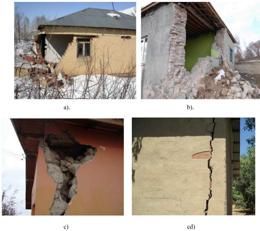
Fig. 12. Corner damages in masonry structures, a) Bingöl (Photos by M.E. Öncü, A. Karaşin), b) Van (Photos by B. Yön, M. E. Öncü), c) Kovancılar (Photos by B. Yön, M.E. Öncü) and d) Maden (Photos by B. Yön).
