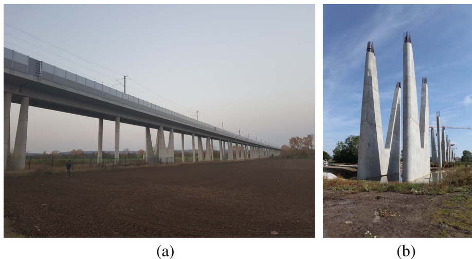
Fig. 16. Gänsebach Viaduct (Right photo: Störfix).
